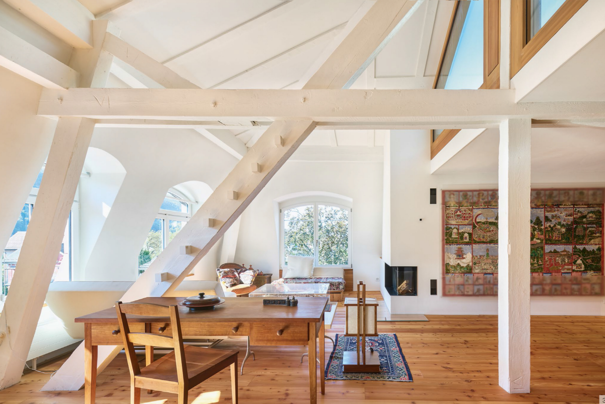
3 Der ursprünglich dunkelbraun gebeizte Dachstuhl wurde analog den Wänden weiss gestrichen und nimmt sich dadurch zugunsten des Raumes in seiner Präsenz zurück.
